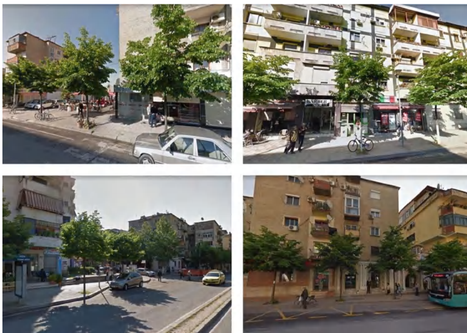
Figure 45. Imazhe të gjendjes aktuale në rrugën « Bardhyl »
